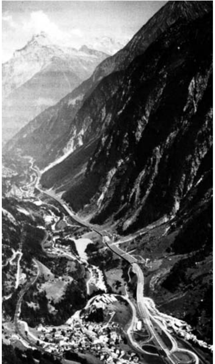
Die N2 bei Wassen. Gut sichtbar in der Bildmitte sind die Lawinengalerien beim Pfaffensprung.
