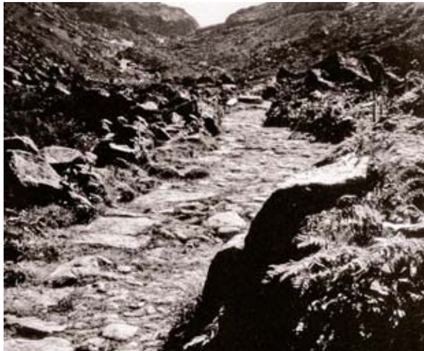
Der Saumpfad mit dem seitlichen Plattenbelag beim Mätteli oberhalb von Hospental.
