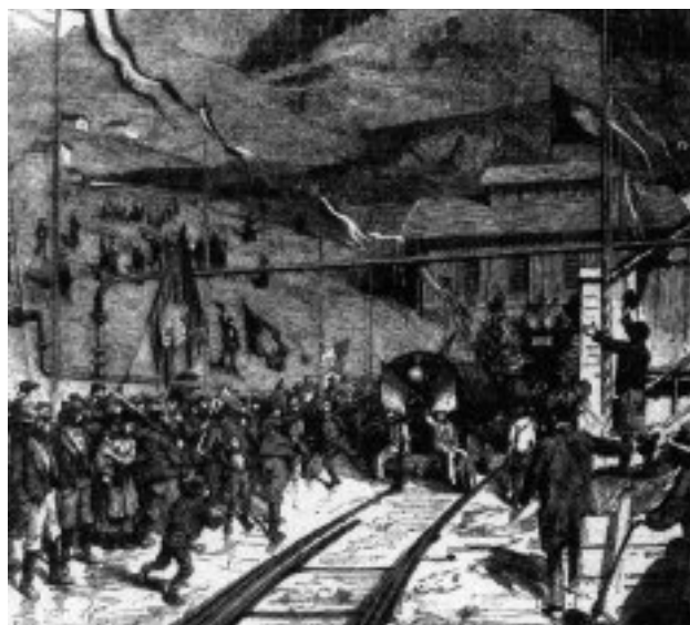
Geschmückter Bauzug in Airolo nach dem Tunneldurchstich 1880.
