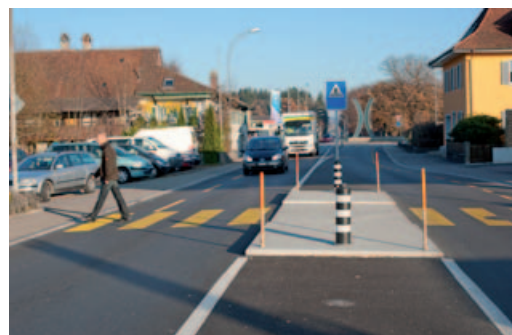
Nach dem Umbau.
